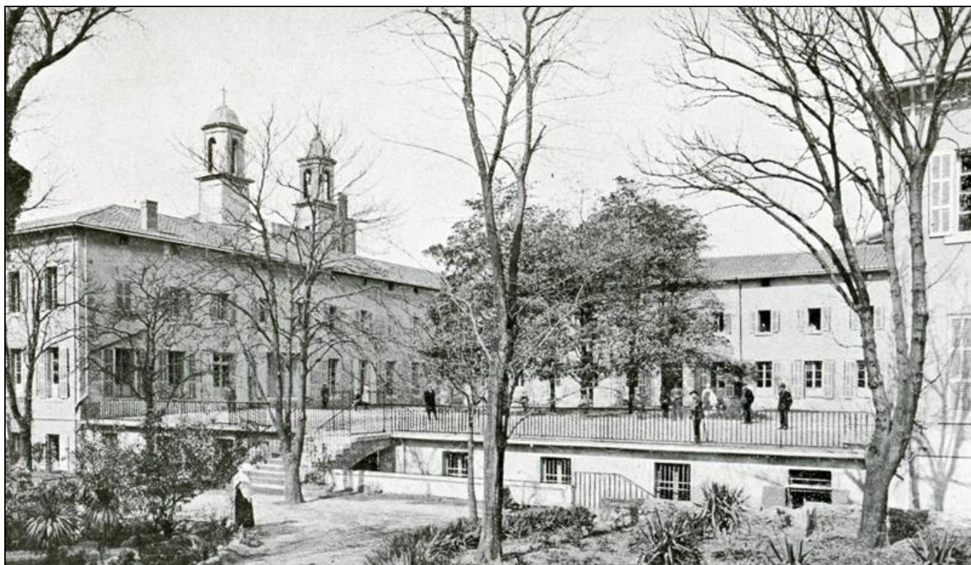
Fig. 3 – Vue générale de l'hôpital
