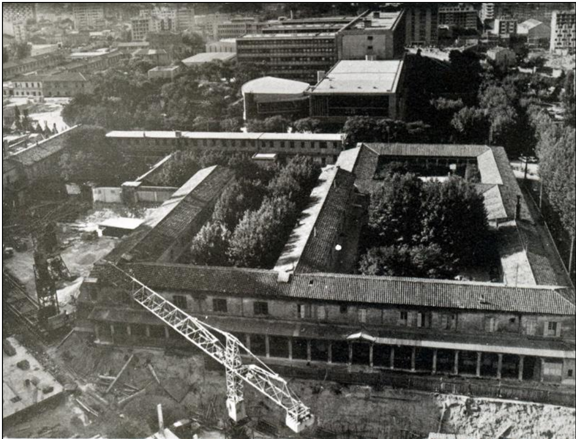
Illustration 10 - Destruction de la vieille Timone et début des travaux du C.H.U.
