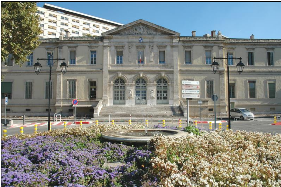
Illustration 3 - Bâtiment administratif sur les plans de l'architecte Pichon
