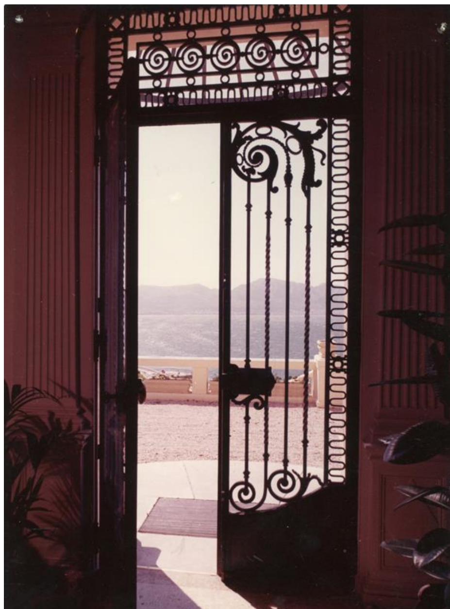
Porte grillagée de l'entrée
